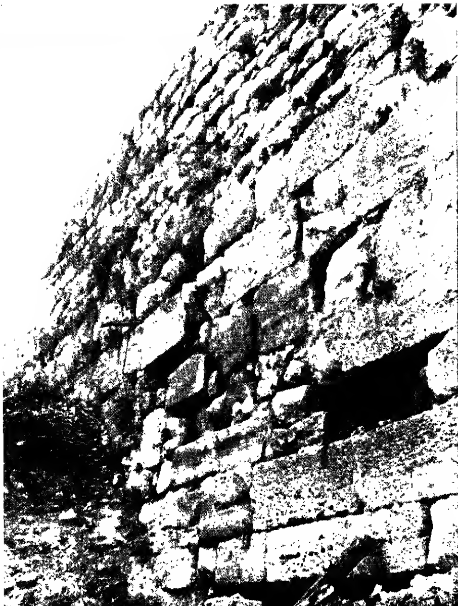
FIG. 6. — Mur nord du terrassement qui soutenait l'église.
